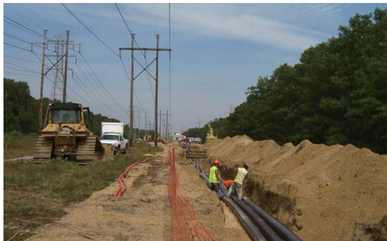
图5. 纽约州长岛电力当局 600m、138kV 输电电缆项目中 HTS 电缆管道的安装 (LIPA 供图)。
