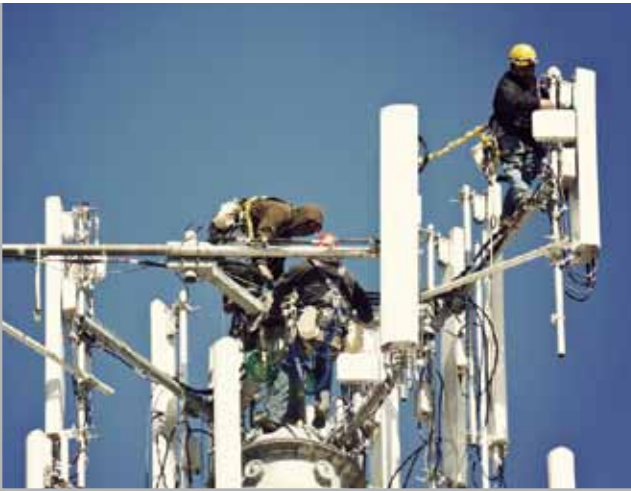
图1：利用合适的保护器件可提高基站可靠性，最大限度减少现场维修。
