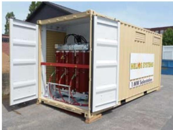
图 1: HSC1000S——通过打开的门可以看见集成的中压变压器。
