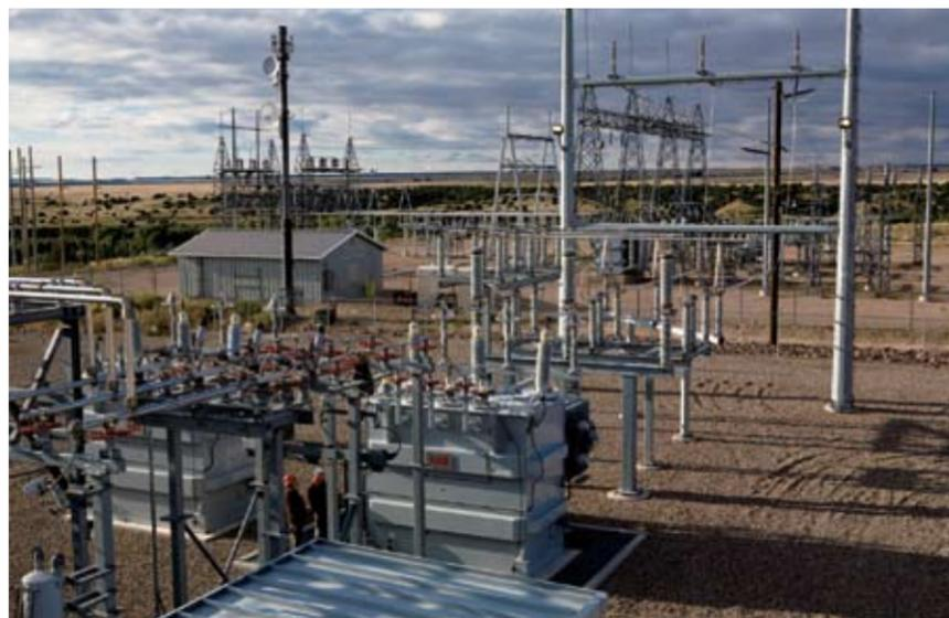
图2: 一款新型模块化变电站, 是由ABB为美国一家主要电力公司在科罗拉多建造的。采用IEC 61850标准的变电站自动化将帮助电力公司更好地监控新型智能电网上的设备。
