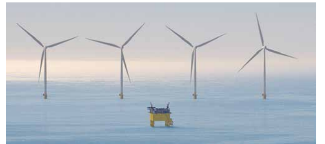
图 2. 位于图片中间位置的是变流站。电力电容器在这里将电力调整平稳。
